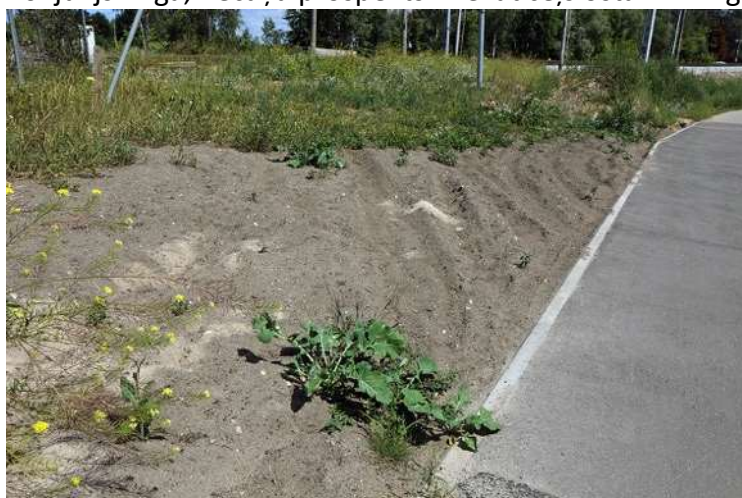
10. jūlijs. Rīga, Vecāķu prospekts. Pievadceļš ostām "Mīlgrāvis" un "AlfaOsta". Paraugs 6.2.
