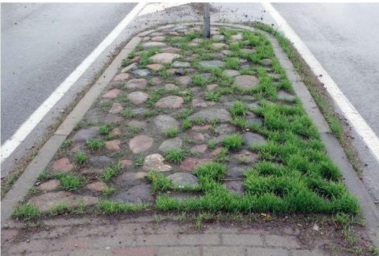
30. septembris. Bauska, apļveida krustojums pie Neste. Labība uz drošības salīņas. Paraugs 33.4.
