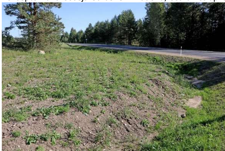
16. septembris. Šoseja Gulbene – Madona, Cesvaines apkārtnē. Rapsis uz jaunveidotām ceļa struktūrām. Paraugs 27.2.
