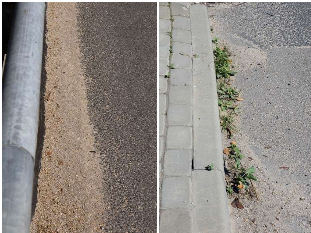
15. augusts. Iecava, Baldones ielas tilts pār Iecavas upi. Pievadceļš uz "Iecavnieks & Co". Paraugs 14.1. Daudz izbīrušu sēklu.
