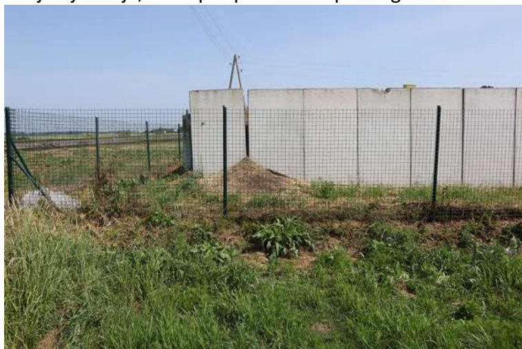
21. jūnijs. Eleja, LatRaps apkārtnē. Blakus atkritumu novietnei, redzams bojājums, kur izbirst materiāls. Paraugi 1.1 – 1.4.
