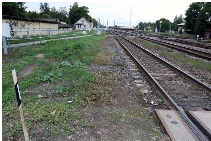
29. augusts. Jēkabpils, dzelzceļa pārbrauktuve uz Madonas ielas. Piebraucamais ceļš uz "Elagro Trade". Paraugs 16.6.
