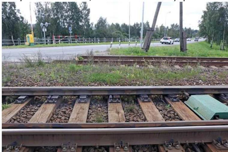
4. septembris. Tukums, Zemītes iela. Dzelzceļa pārbrauktuve. Paraugs 20.2.
