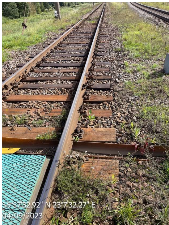
4. septembris. Tukums, Zemītes iela. Dzelzceļa pārbrauktuve. Paraugs 20.2.
