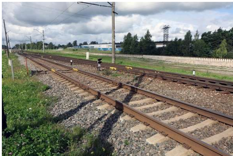
4. septembris. Tukums, Zemītes iela. Dzelzceļa pārbrauktuve. Paraugs 20.2.
