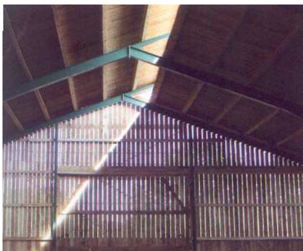
4.5. att. Aitu kūts ar redeļu sienu un ventilācijas - apgaismojuma lūku jumtā
