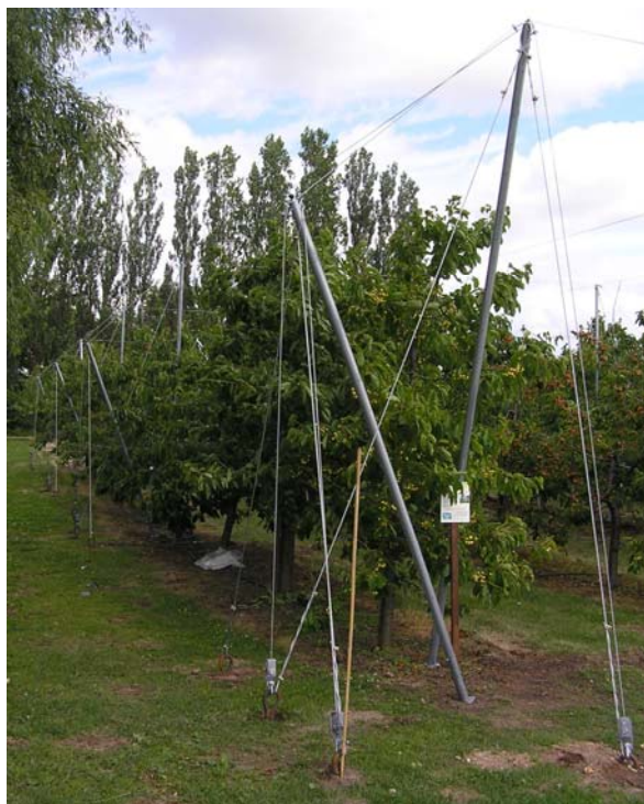
2.1.29.att. Uzstādītās konstrukcijas aizsargsegumu uzklāšanai.
